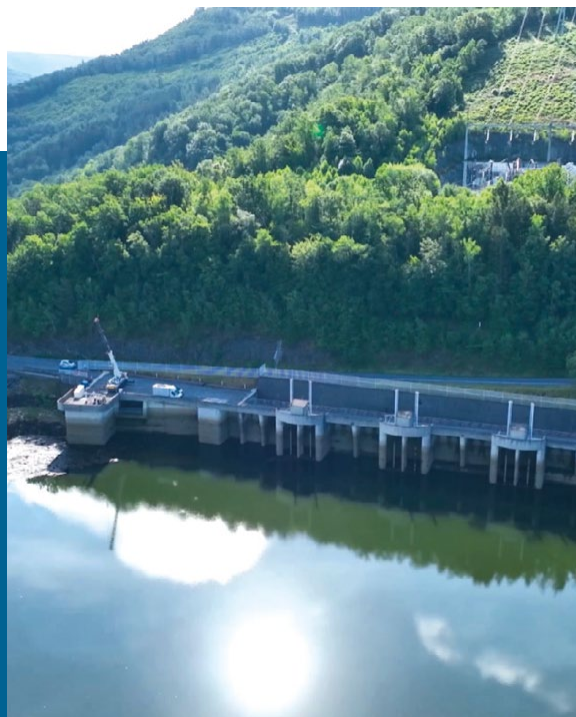
Rénovation du barrage hydro-électrique de Revin (France).
