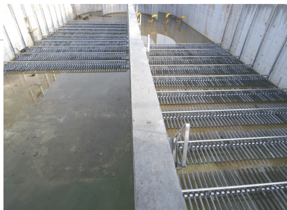
Particulièrement adapté à l'augmentation de la capacité des stations d'épuration existantes, le réaménagement des bassins d'aération est un élément clés du process BeFlow® AGS permettant jusqu'à doubler la capacité de traitement.
