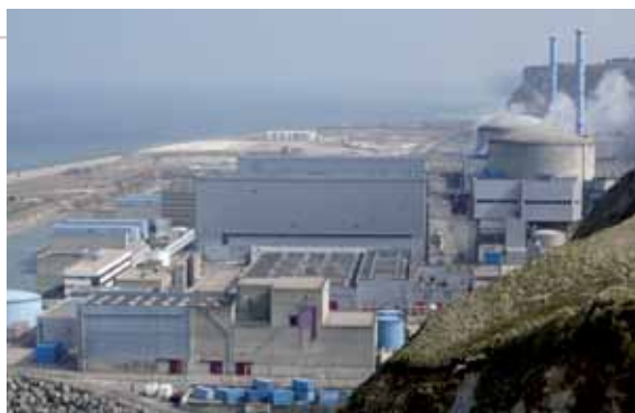
La prolifération d'organismes encrassants tels que les microbes, les algues et les moules réduit progressivement l'efficacité du transfert de chaleur et conduit à l'obstruction des circuits d'eau de refroidissement des industries côtières et des centrales électriques.
