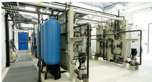
Traitement en rejet zéro des effluents d'une ligne de traitement de surface, 2 m 3 /h (France)
