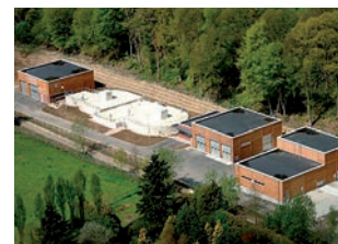
Station d'épuration, 13 000 EH (Louvain-la-Neuve, Belgique)
