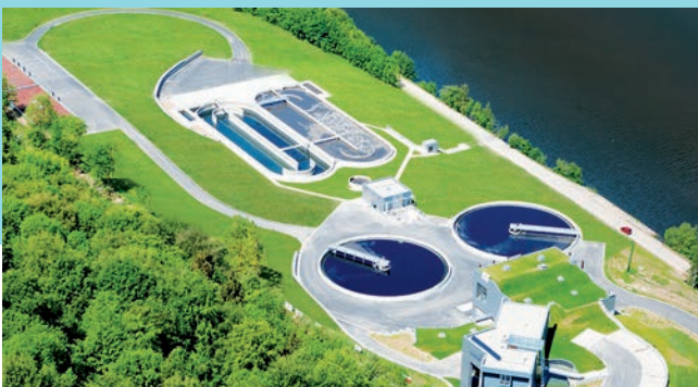
Station de traitement des eaux usées municipales, 93 100 EH (Namur, Belgique)
